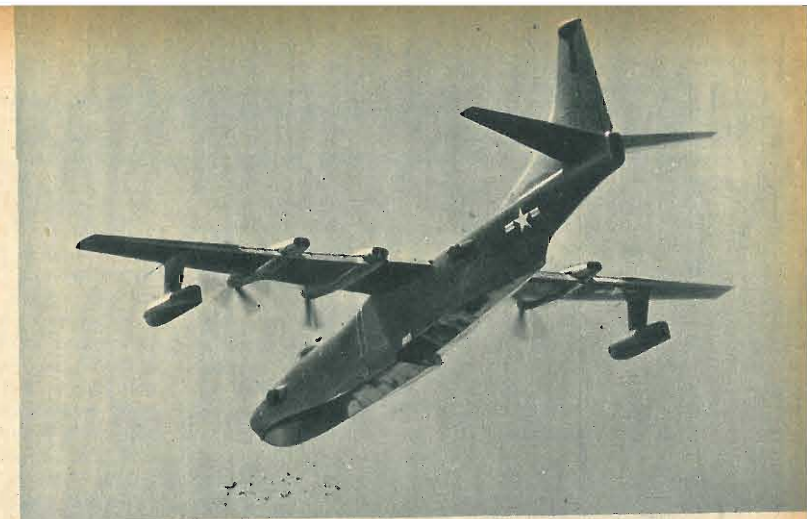
• L'idrovolante Convair XP5Y-1 della Marina americana, mosso da quattro Allison T-40 da 5500 cav, vola a 640 km/h pur pesando 63 tonnellate.
