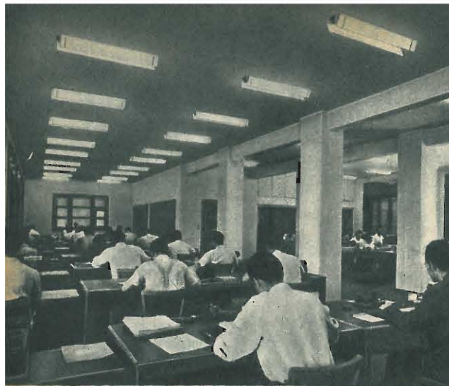
• Semplice illuminazione di locale da ufficio con serie di lampade isolate su soffitto liscio.
